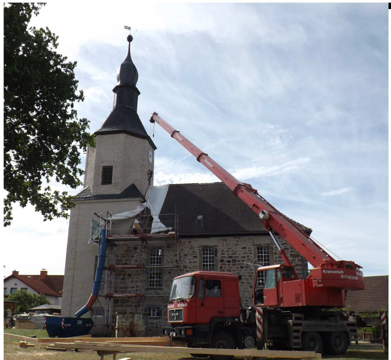
Dachsanierung in Großhelmsdorf
