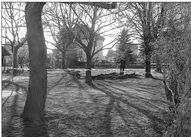
Der erste Spatenstich
